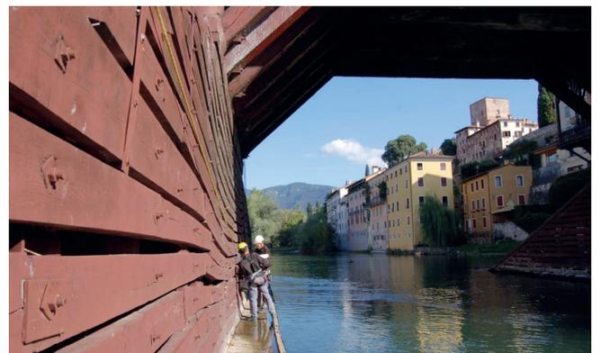
*Indagine diagnostica sulle pile in legno del ponte di Bassano*
